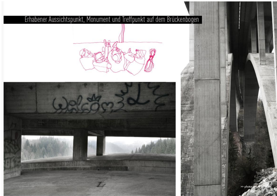
Abbildung 12: Erhabener Aussichtspunkt, Monument und Treffpunkt auf dem Brückenbogen
