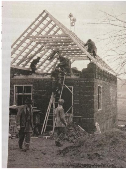
Darstellung 8: Gleichenfeier des Tiefkühlhauses Empersdorf 1959
